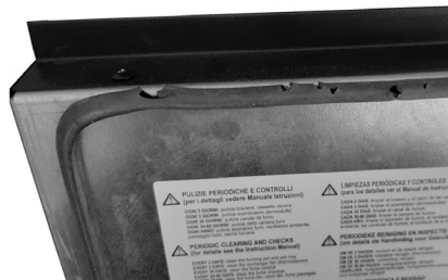
Fig. 23 - Verschlechterte Dichtung
