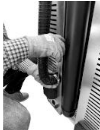
Fig. 62 - Rohr der Heizluft einstecken
