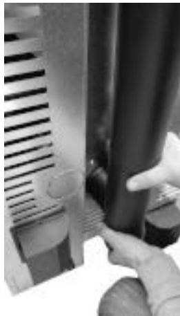
Fig. 61 - Rohr Durchm. 80 mm einstecken
