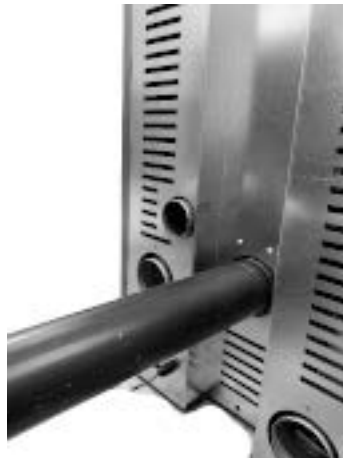
Fig. 53 - Anschluss des Rauchgasauslasses
