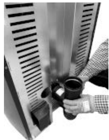
Fig. 56 - T-Anschlussstück anschließen
