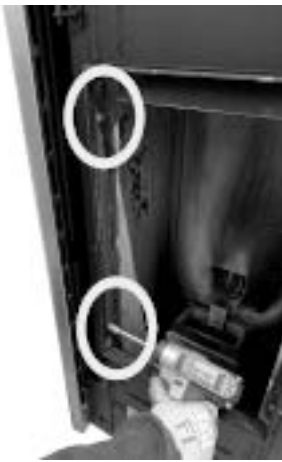
Fig. 87 - Die Sechskantschrauben entfernen
