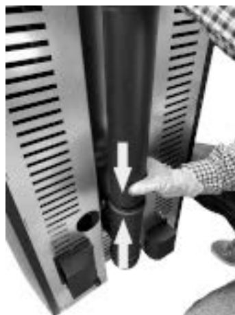
Fig. 58 - Die Rohre anschließen
