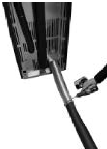
Fig. 72 - Rohr D. 80 mm anschließen
