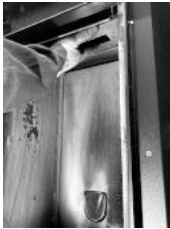
Fig. 88 - Die Stirnseite des Feuerraums 1 entfernen
