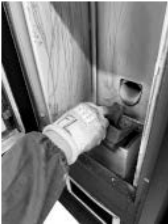
Fig. 81 - Die Brennschale entfernen
