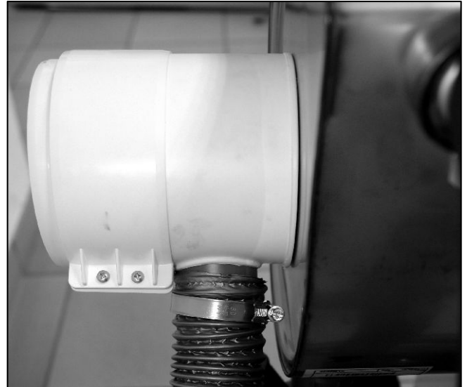
Abb. 10: Anschluss DN80/125 aufstecken und den Zuluftschlauch mit der Bandschelle befestigen.
