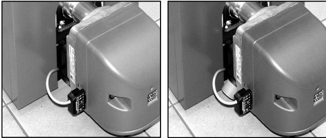
Abb. 1: Brenner ohne und mit Luftstützen
