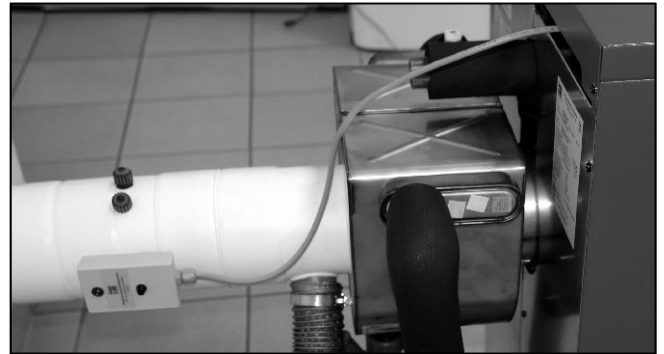
Abb. 11: Abgaswärmetauscher mit Anschluss DN80/125 und Kesselanschluss mit Abgastemperaturbegrenzer DN80/125.
