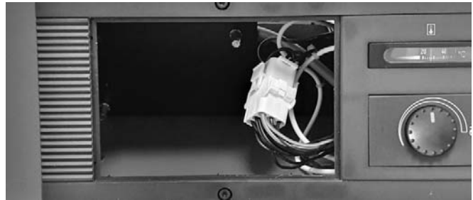
Abb. 105: Aufgesteckter Brückenstecker.
