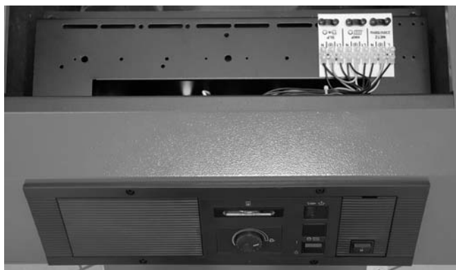
Abb. 27: Kessel-Grundschaltfeld ohne Regelung und Montagebereich für Anschluss-Klemmbrett
