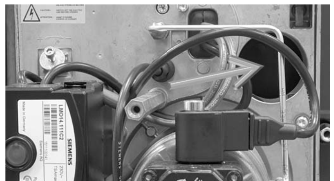
Abb. 9: Luft-Ansaugöffnung des Brenners BNR 100
