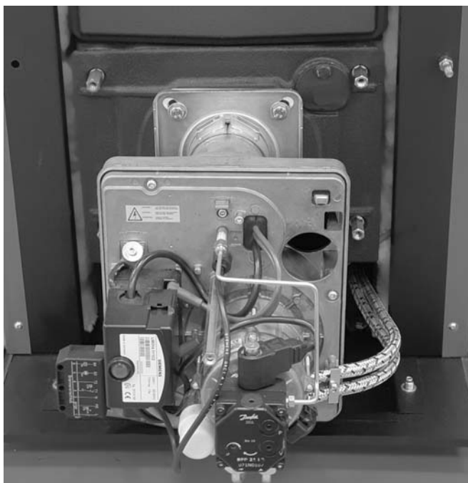
Abb. 7: Montierter Öl-Blau-Brenner
