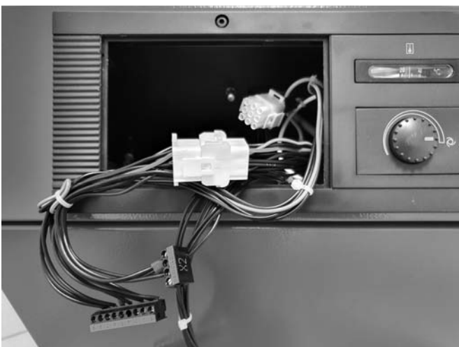
Abb. 33: Anschlussstecker für den Regler.
