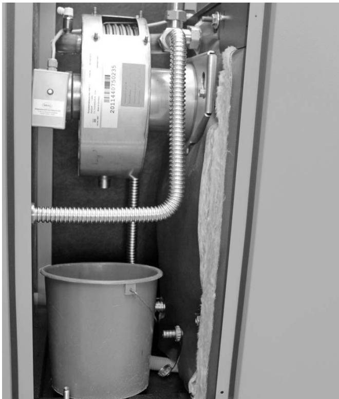
Abb. 89: Zur Reinigung vorbereiteter RWT
