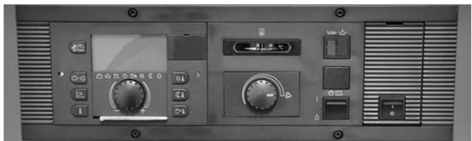
Abb. 35: Montierte THETA+ im Kessel-Grundschaftfeld.
