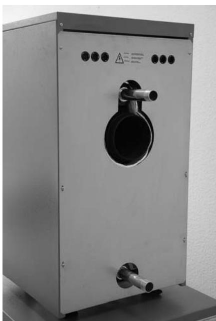
Gewindenippel 1" eindichten und am Kessel montieren (Vor- und Rücklauf).
