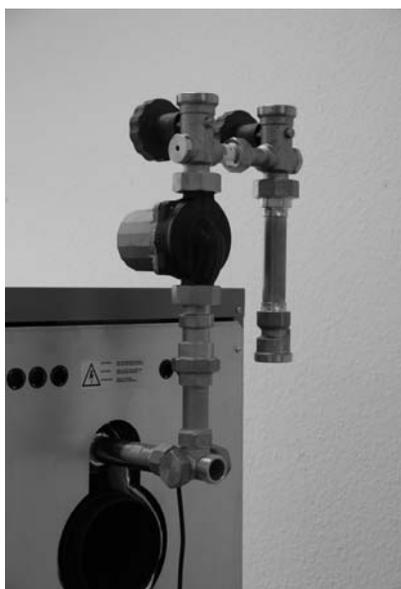
Pumpengruppe am Kesselvorlauf montieren dazu die Isolierung entfernen.
