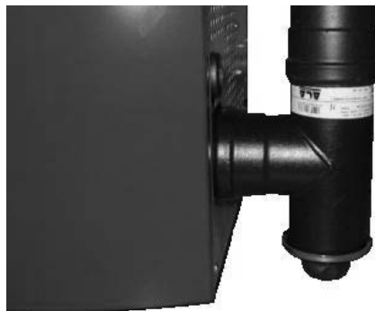
Fig. 55 - Reinigung des Rauchgaskanals
